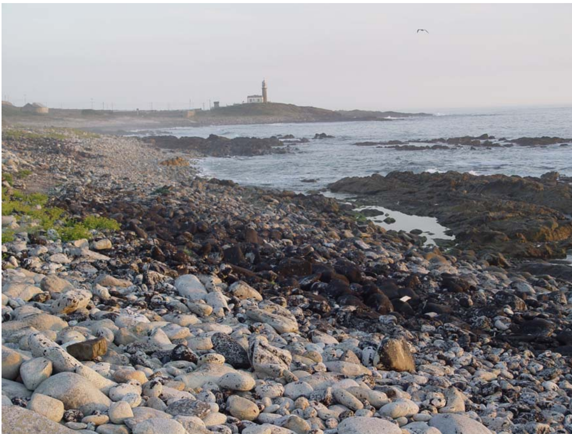
Foto 2. Vista xeral. A zona foi afectada de xeito irregular.
